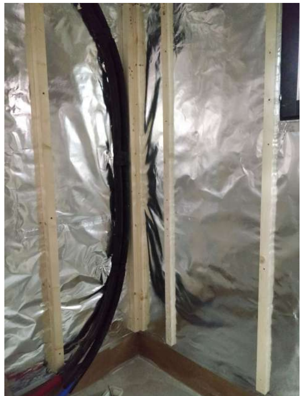
Teemu Hast 20.04.2020 13:50 Alumiinipaperit asennettu.
