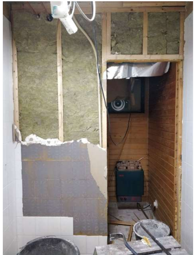
Teemu Hast 14.04.2020 11:14 Purku käynnissä.
