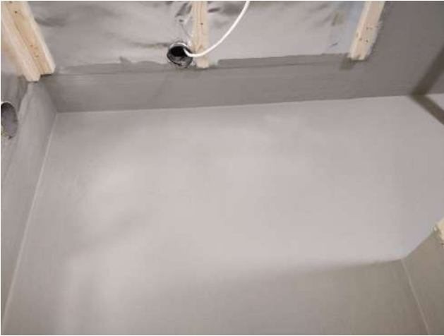
Teemu Hast 22.04.2020 08:02 Vesieristystyöt valmiina
