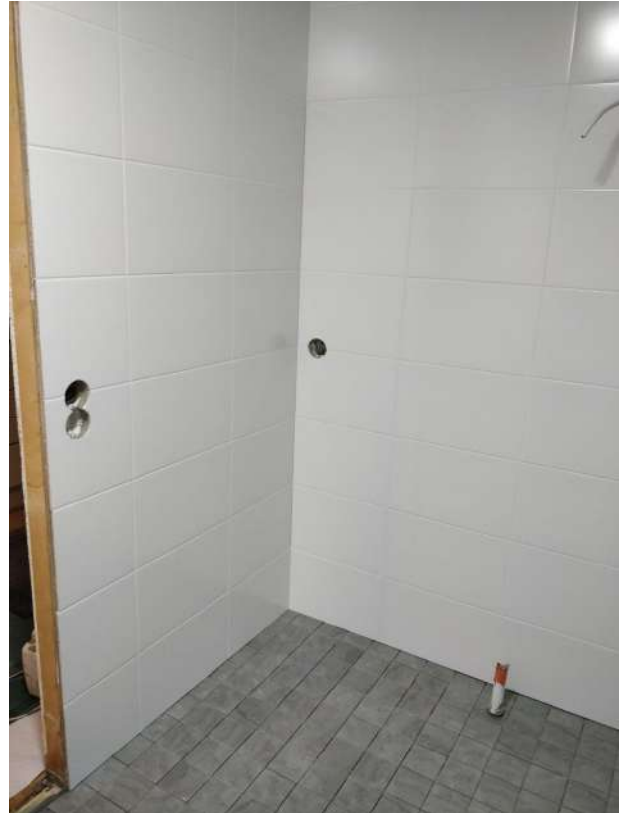
Teemu Hast 24.04.2020 08:45 Laatoitustyöt valmiina.
