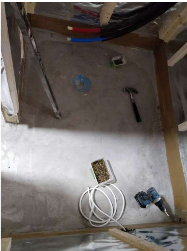
Teemu Hast 20.04.2020 13:50 Lattia tasoitettu.
