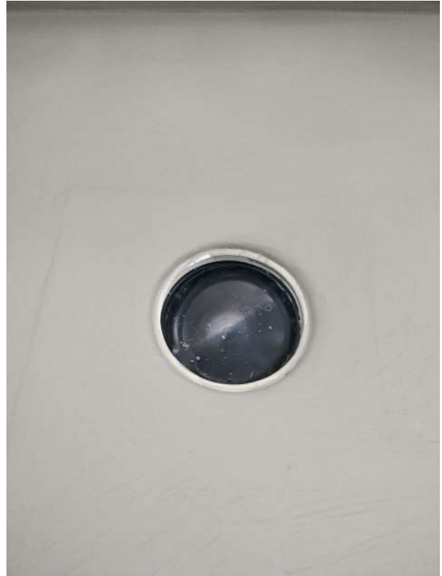
Teemu Hast 22.04.2020 08:03 Kaivon vesieristysliitos.
