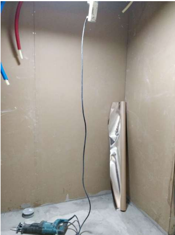
Teemu Hast 20.04.2020 13:48 Pohjatyöt valmiina.
