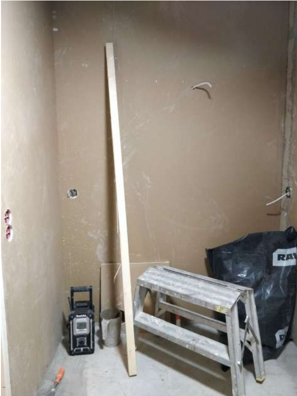
Teemu Hast 20.04.2020 13:49 Pohjatyöt valmiina.
