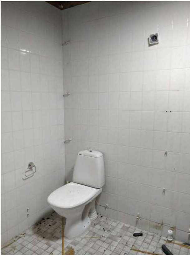
Teemu Hast 14.04.2020 11:13 Purku käynnissä.
