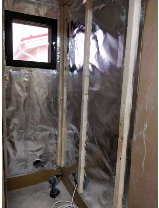
Teemu Hast 20.04.2020 13:50 Alumiinipaperit asennettu.
