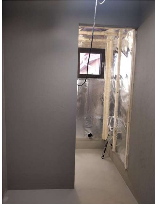
Teemu Hast 22.04.2020 08:07 Vesieristystyöt valmiina.
