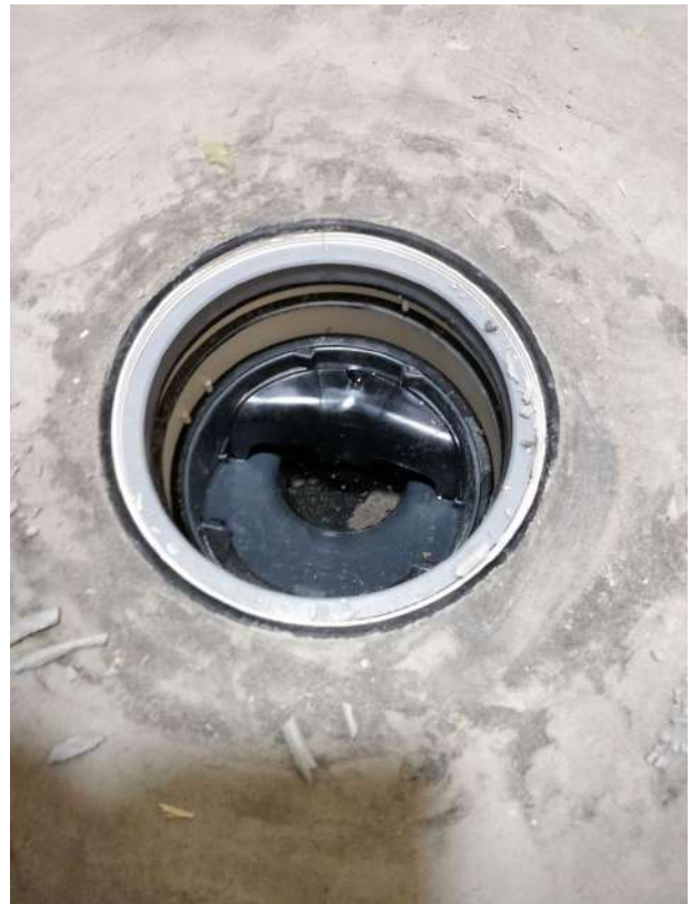
Teemu Hast 20.04.2020 13:51 Kaivo uusittu.
