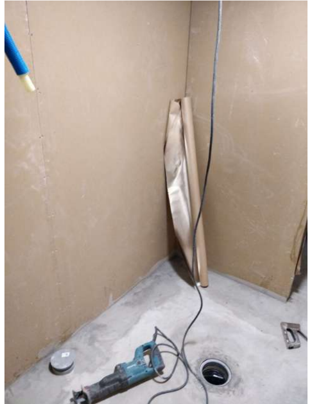
Teemu Hast 20.04.2020 13:49 Pohjatyöt valmiina.
