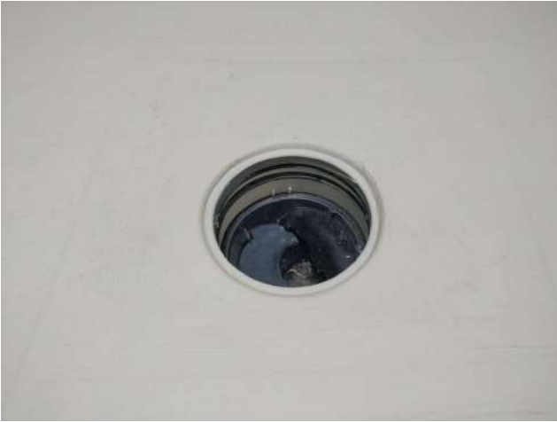
Teemu Hast 22.04.2020 08:07 Kaivon vesieristysliitos.
