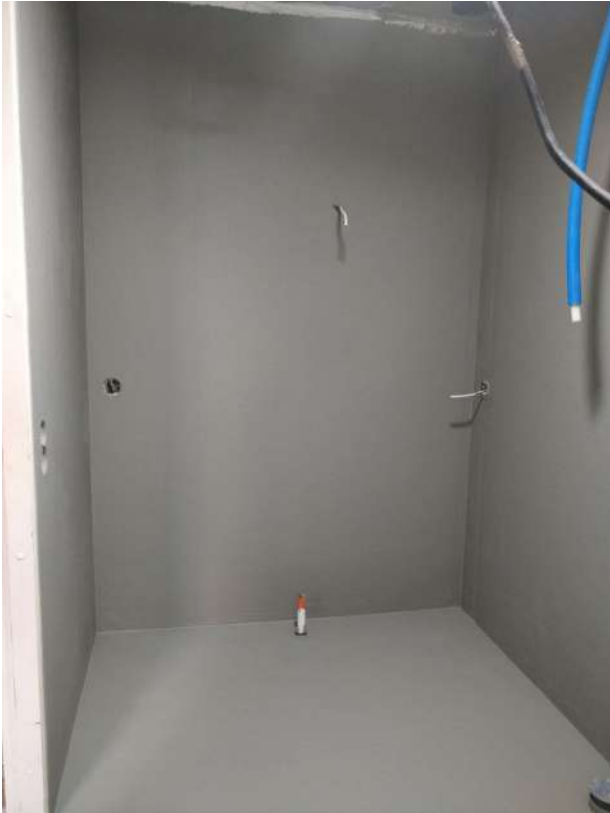
Teemu Hast 22.04.2020 08:06 Vesieristystyöt valmiina.
